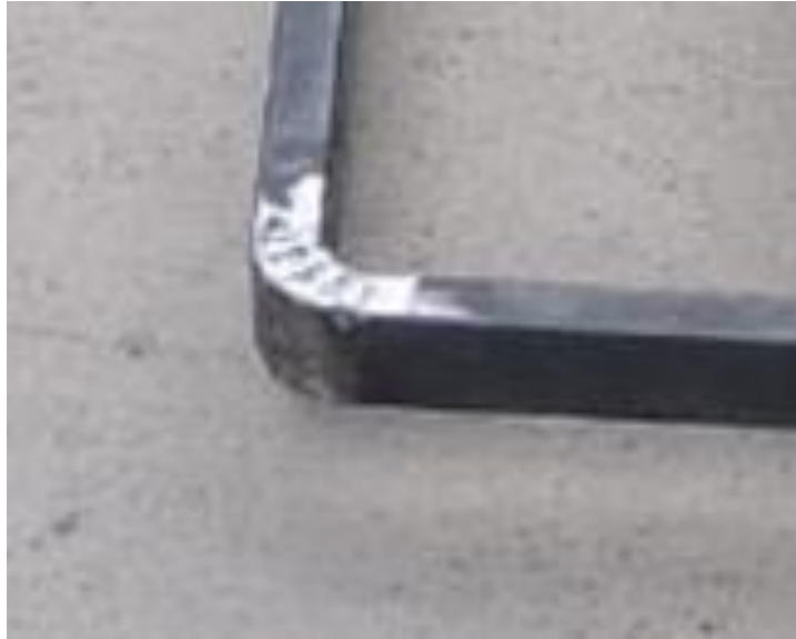
Figura 21 Curvado del perfil estructural por medio de cortes en ángulos
