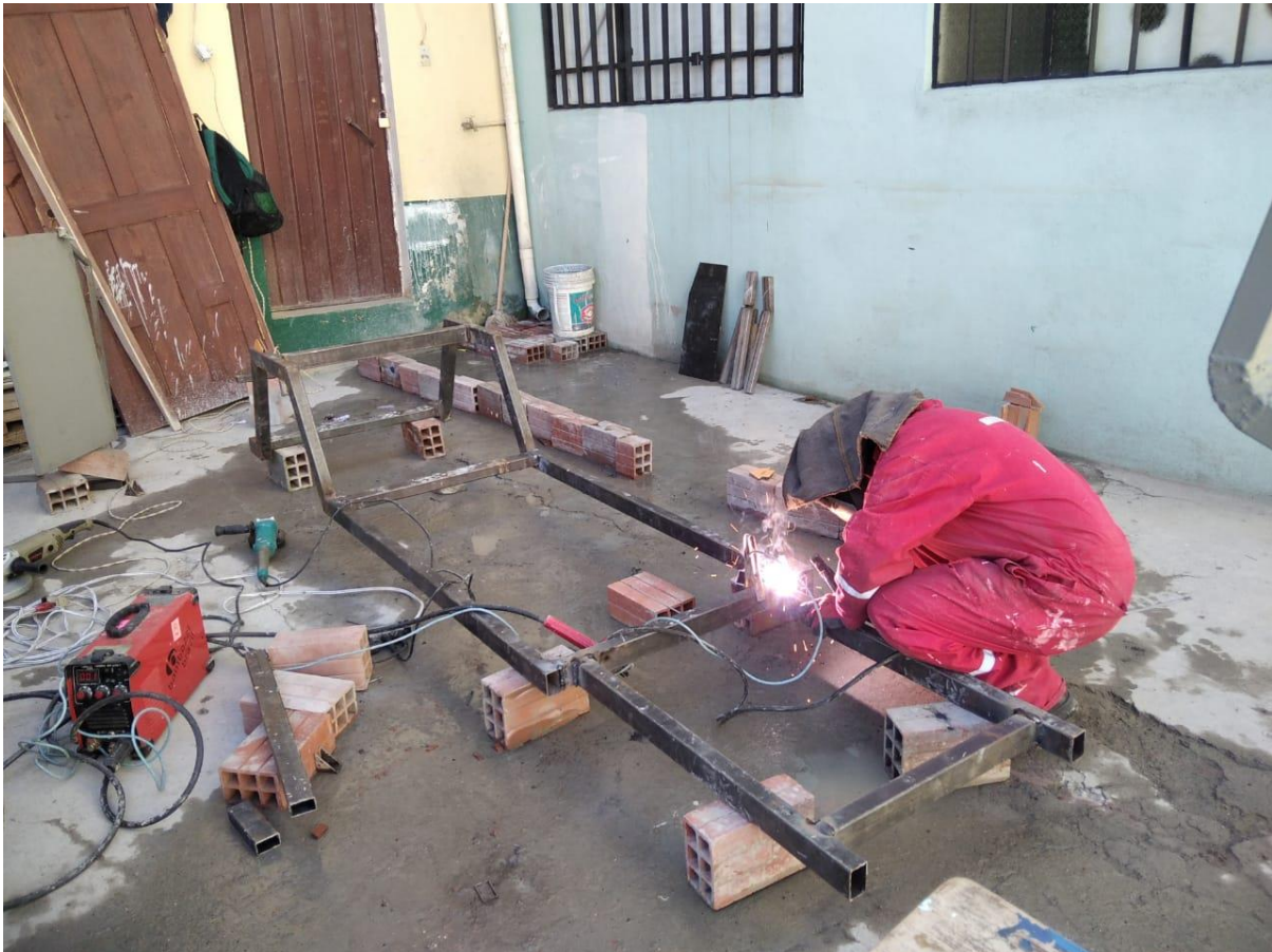
Figura 22 Soldadura con arco eléctrico y utilizando como material de aporte el electrodo E 7018
