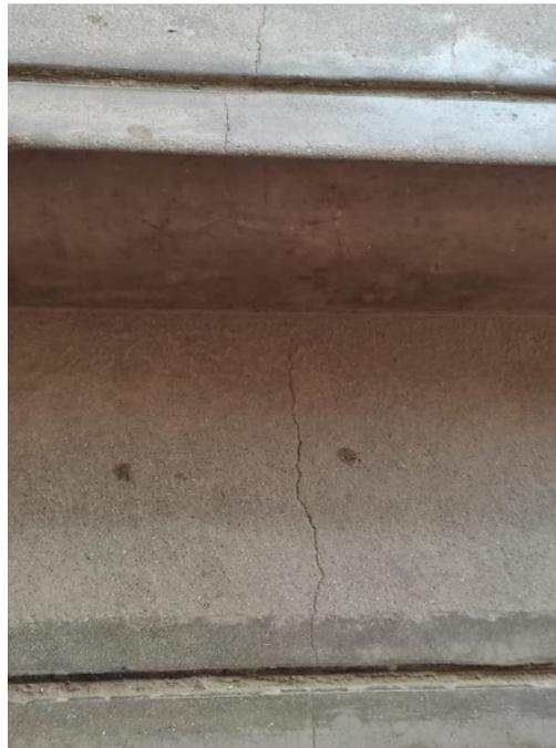
*Figura Nro 9. Fisuras en gradas Bloque B*
