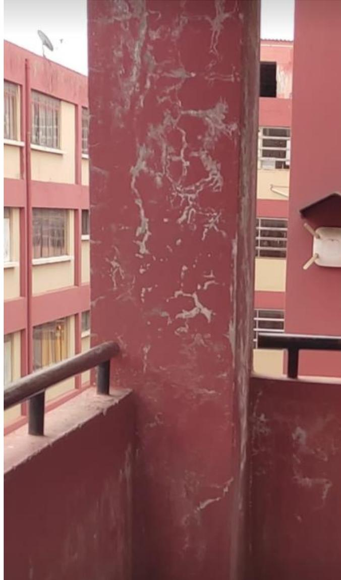
*Figura Nro 11. Microfisuras en Bloque B*
