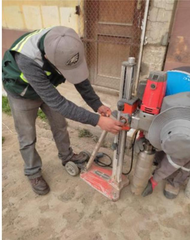
*Figura Nro 22. Preparación para la toma de testigos*
