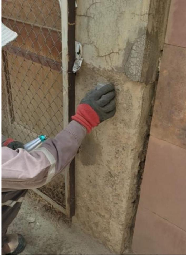
*Figura Nro 18. Preparación de la superficie*
