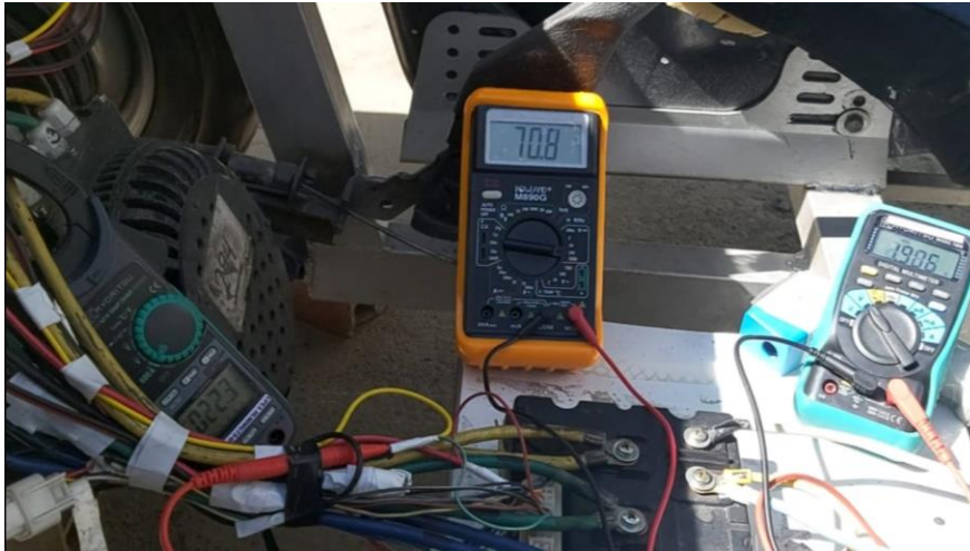
Figura 71. Mediciones de los parámetros eléctricos
