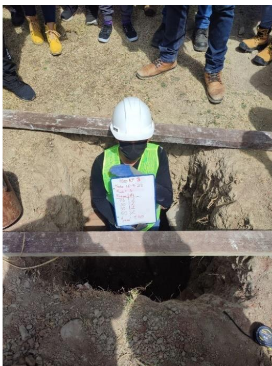
Figura 50. In-situ ensayo SPT pozo 3
