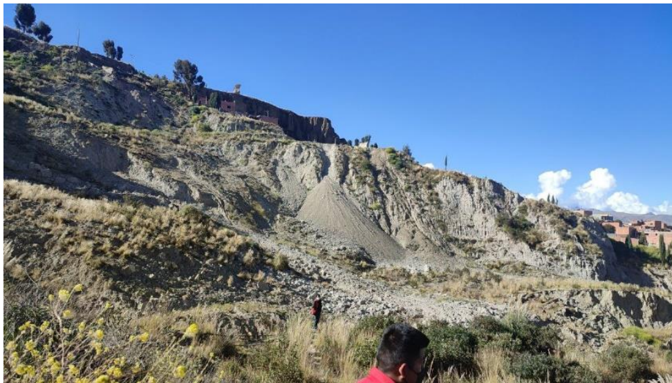
Figura 23. Identificación del talud de deslizamiento
