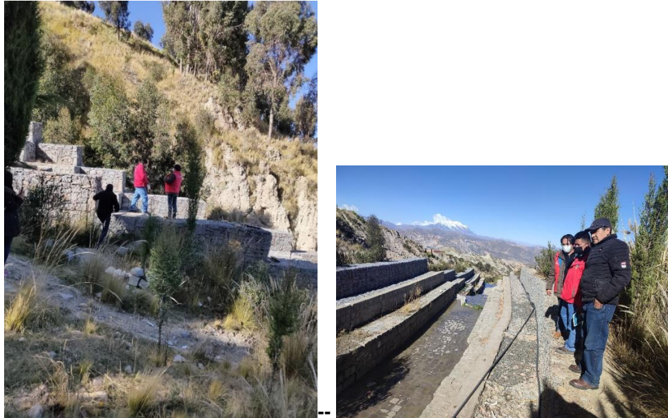
Figura 20. Obra civil-Canalización antiguo en talud Alpacoma
