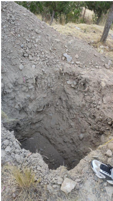
Figura 44. Excavación a cielo abierto pozo 7
