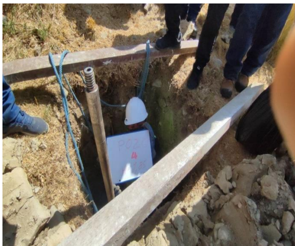
Figura 51. In-situ ensayo SPT pozo 4
