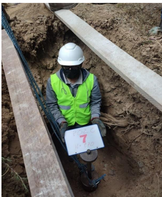
Figura 54. In-situ ensayo SPT pozo 7
