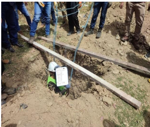
Figura 53. In-situ ensayo SPT pozo 6
