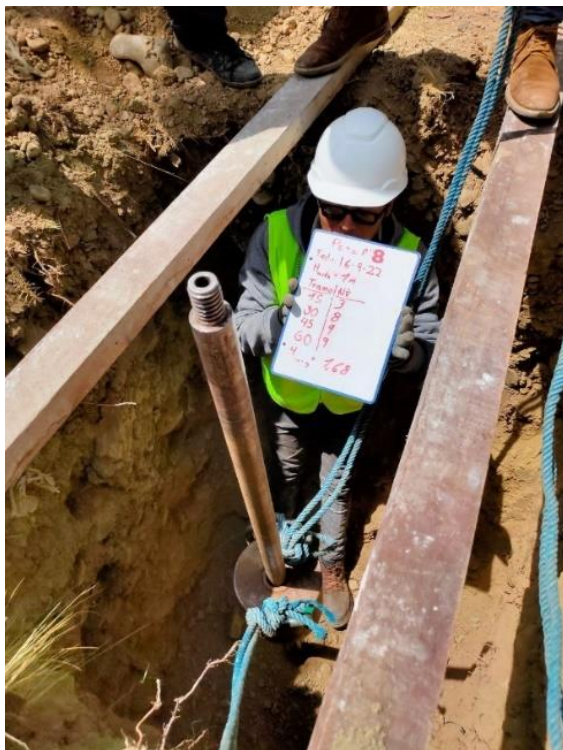
Figura 55. In-situ ensayo SPT pozo 8
