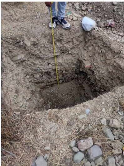
Figura 38. Excavación a cielo abierto pozo 1
