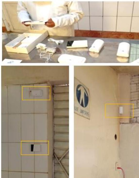
**Figura 16:** Dispositivos instalados del sistema de alarmas
